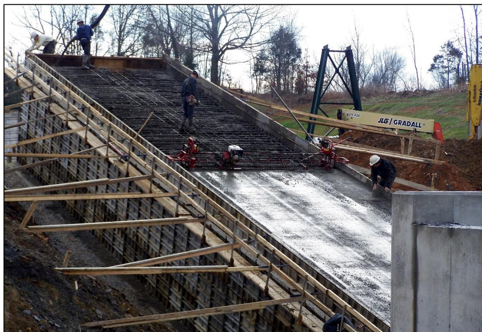
شکل ۴: استفاده از قالب تونلی در سطوح شیبدار
