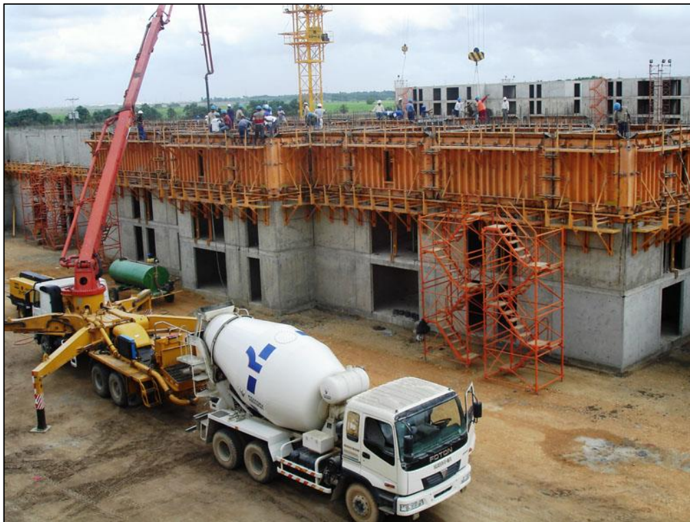
شکل ۳: نمایی از بتن ریزی بخش های آماده شده
